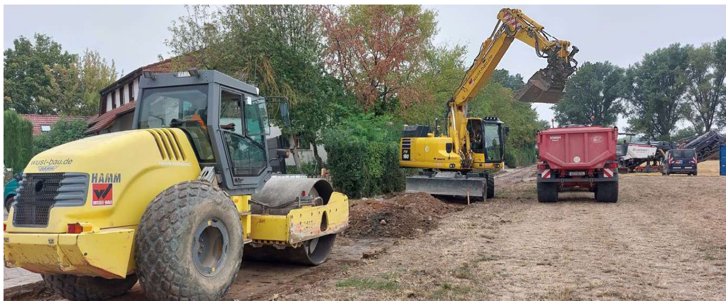
Für die gesamte Baumaßnahme wird ein Zeitfenster von circa 4 Wochen veranschlagt.
